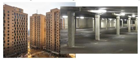
Устройство бетонной плиты пола с применением полипропиленовой макрофибры Strofiber, расход 1 кг/м3 макрофибры, основание монолит.
