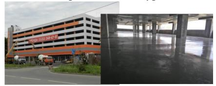
Устройство бетонной плиты пола с применением полипропиленовой макрофибры Strofiber, расход 1 кг/м3 макрофибры, основание монолит.
